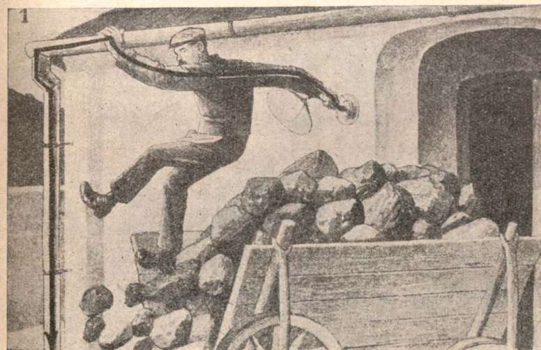
Сл. 8 — Радник додирује наелектрисани гвоздени зидни носач, ствара кратки спој услед чега га струја убија, а може и пожар да изазове.
