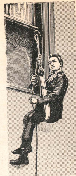
Сл. 94 — Спустање са справом за самоспасавање.
